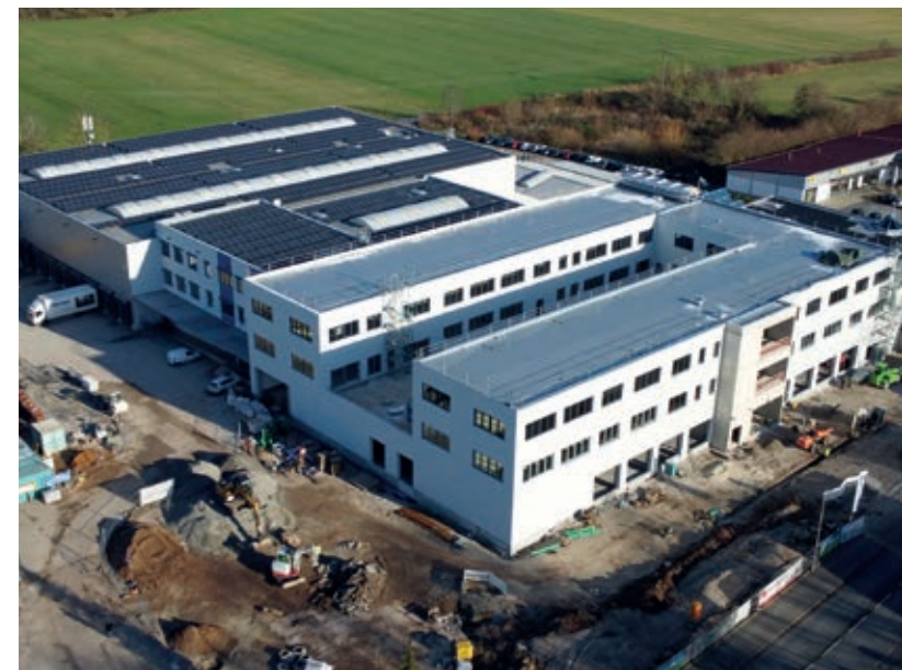
Neubau am Hauptsitz in der Karl-Eibl-Straße, 2024
