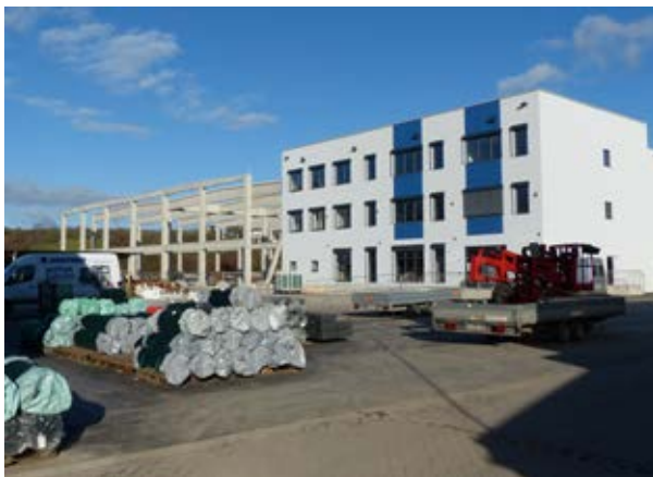
2013 - Neubau des Lagers
